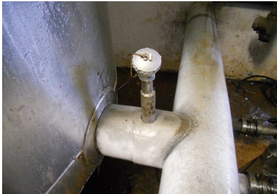
Figura 7 – sensor tipo PT 100
