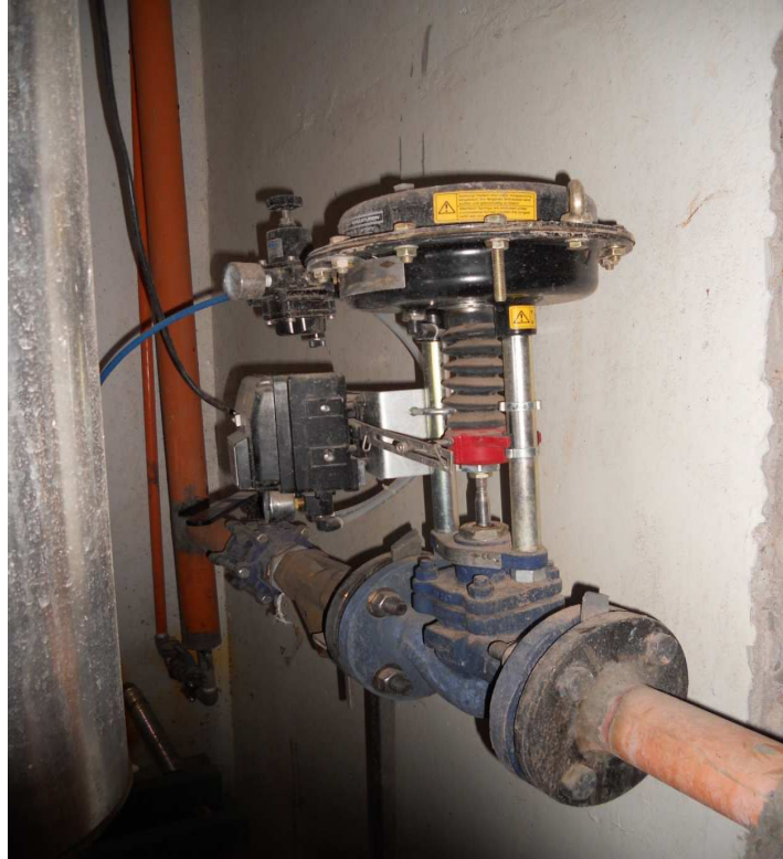
Figura 6 – Válvula proporcional de vapor ARMATUREN modelo DP 32
