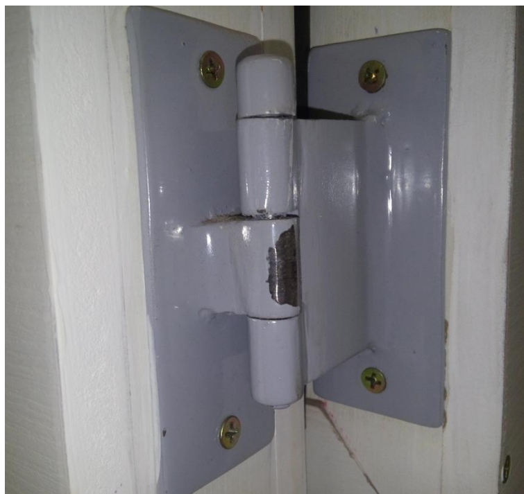
Figura 11 - Dobradiça montada na estufa
