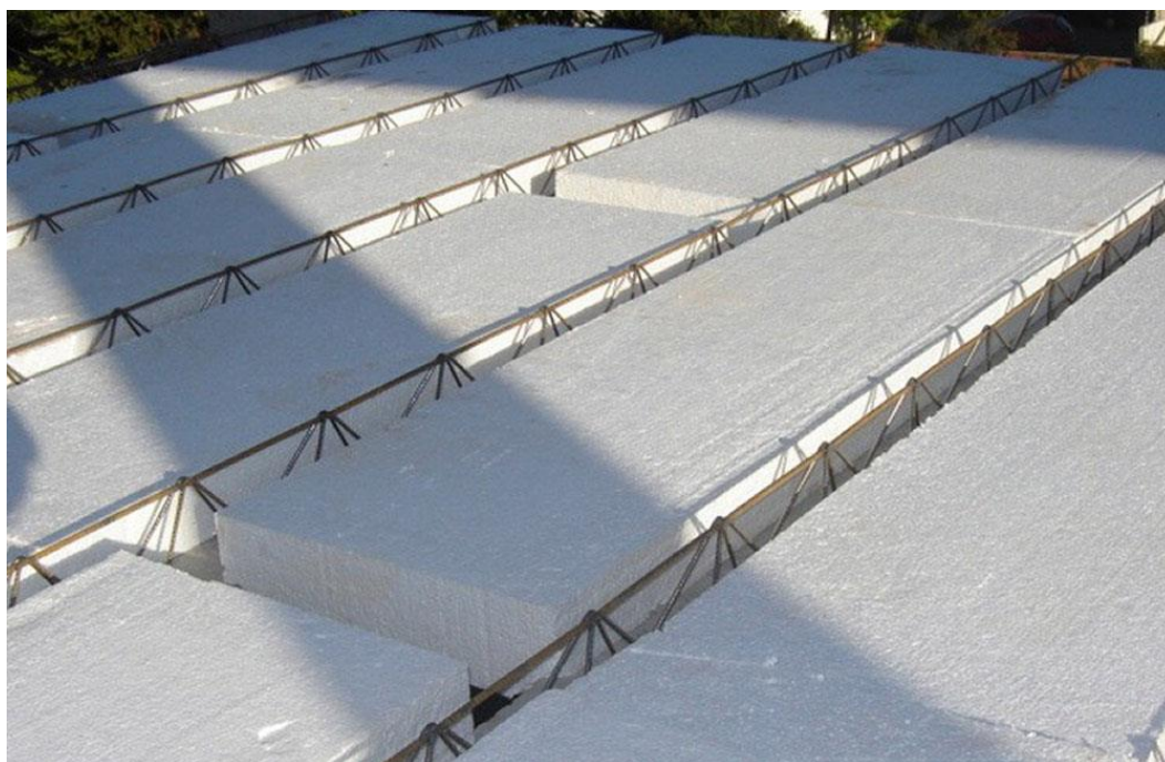
Figura 1- EPS sendo utilizado em Lajes Fonte: Catálogo do produto EPS (ISOSANTAMARIA ®)
