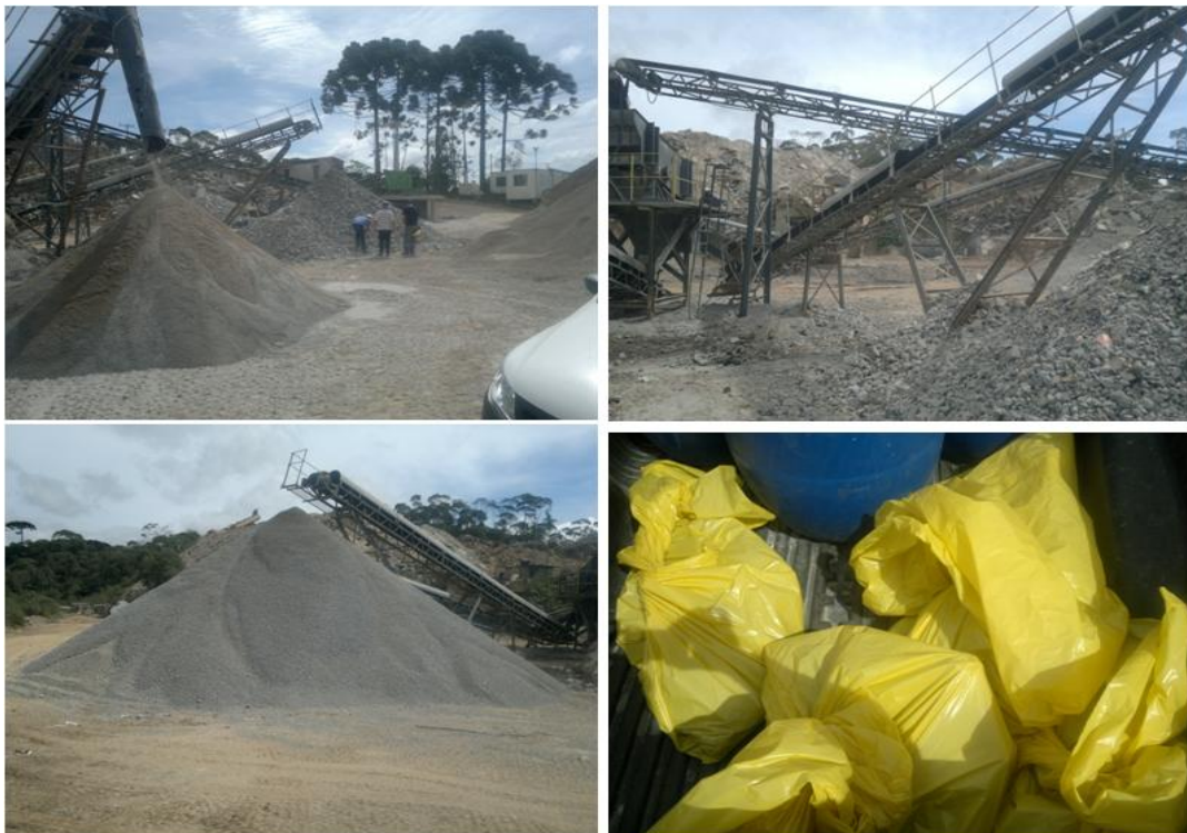
Figura 14 – Coleta dos resíduos sólidos da construção civil reciclados
