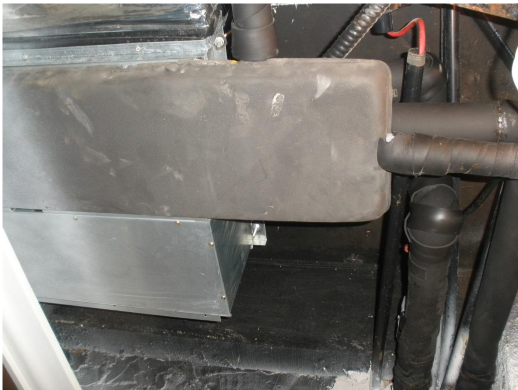
Figura 9: Unidade Fan-coil
