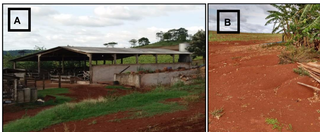
Figura 24 - A - Galpão para recolha da água pluvial; B - Local para construção da cisterna Fonte: Autoria Própria (2017).
