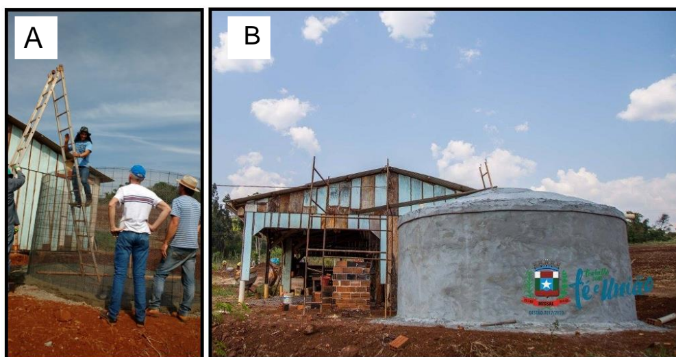
Figura 6 - A - Cisterna em construção no município de Missal; B - Cisterna concluída Fonte: Web Rádio Água (2017).
