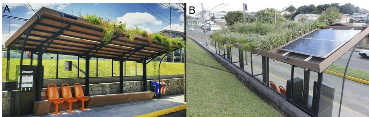
Figura 5 - A - Vista frontal da Parada Verde; B – Telhado Verde e Placas Fotovoltaicas. Fonte: ECOGUIA (2017).
