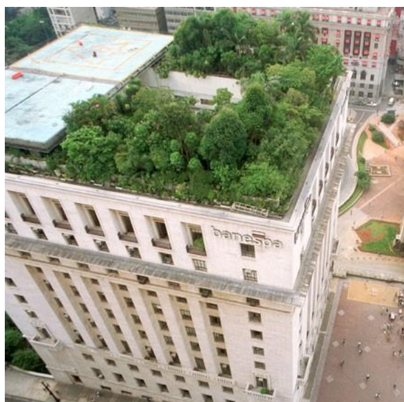
Figura 1 - Telhado Verde da Prefeitura Municipal de São Paulo-SP. Fonte: G1 - Globo (2015).
