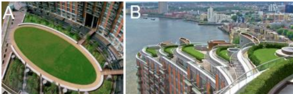
Figura 6 - A - Vista superior do pátio central do edifício; B - Andares com coberturas de Telhado Verde.
