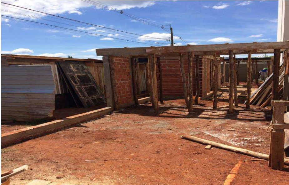
Figura 18 - Muro da frente após cinco dias de trabalho Fonte: O autor.
