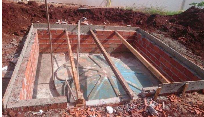
Figura 20 - Início da construção da laje da cisterna Fonte: O autor.
