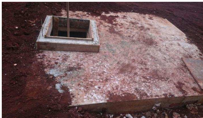
Figura 21 - Término da construção da laje da cisterna Fonte: O autor.
