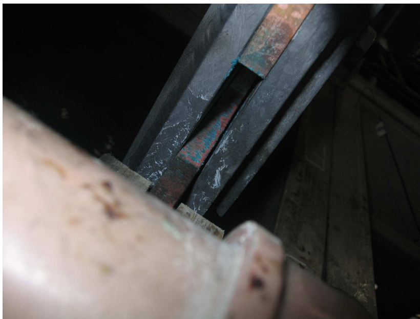
Figura 6 - Dispositivo Antes da Implementação da melhoria Fonte: Autoria Própria
