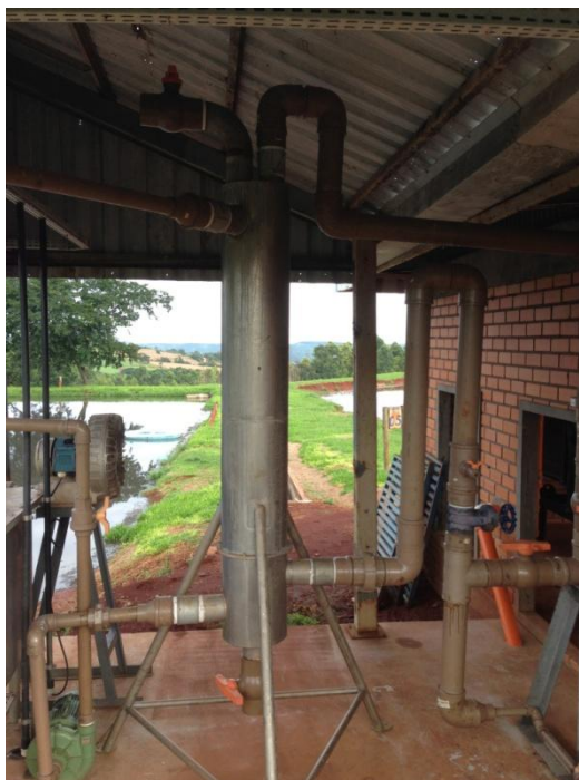
Figura 12 - Sistema de purificação de biogás utilizado na UIA
