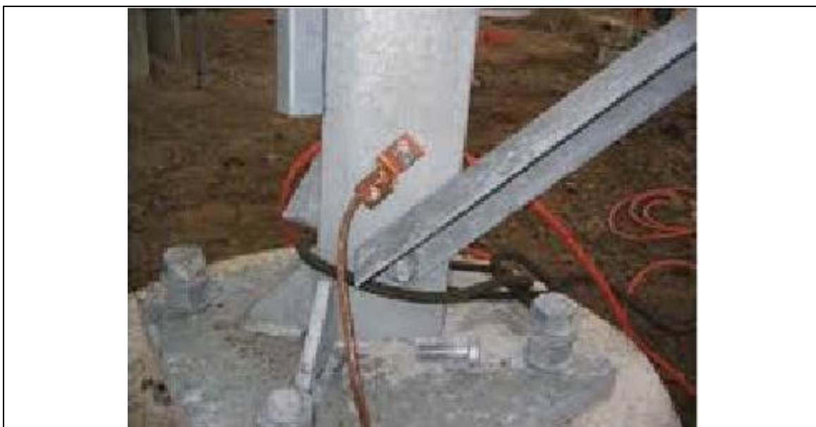
Figura 11- Exemplo de fixação do cabo de aterramento à estrutura metálica da torre. Fonte: Adaptado de Copel (2014).
