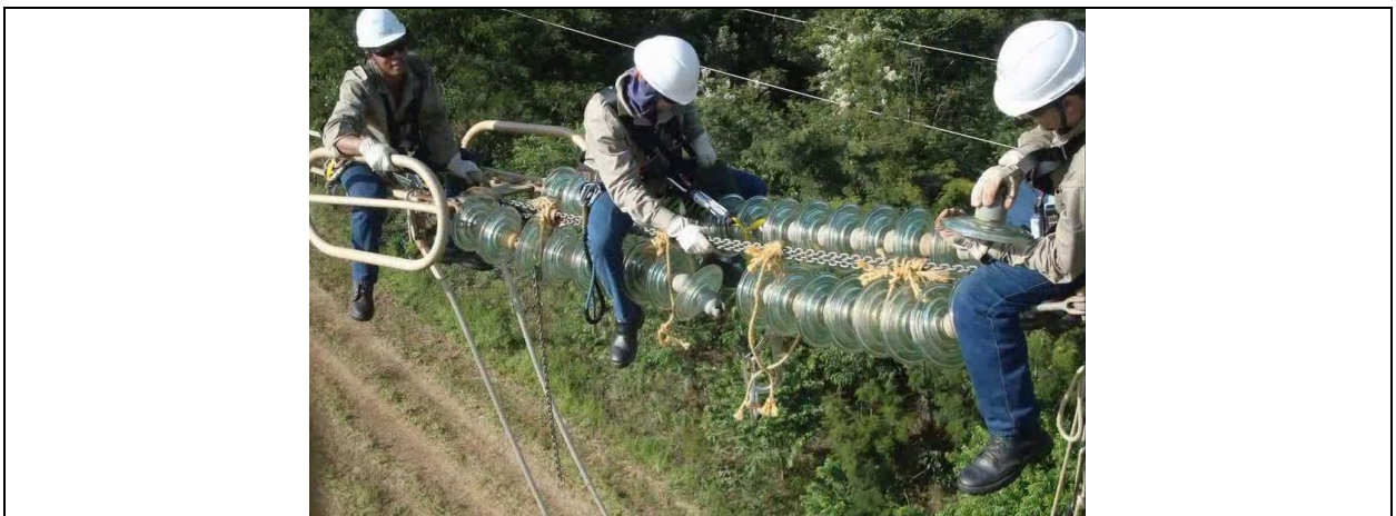
Figura 6– Exemplo de troca de isolador na cadeia. Fonte: Adaptada de Copel (2014).
