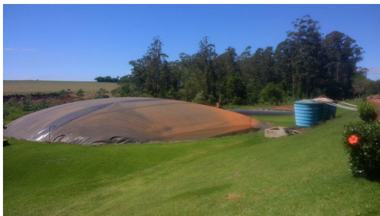
Figura 10 – Biodigestor instalado Fonte: Autorial própria
