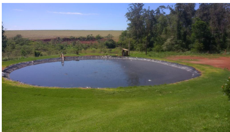
Figura 11 – Lagoa anaeróbia Fonte: Autorial própria
