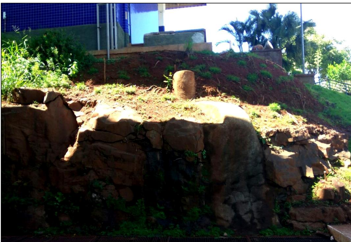
Fotografia 5 – Horizontes de solo visível nas proximidades da ponte da Amizade.
