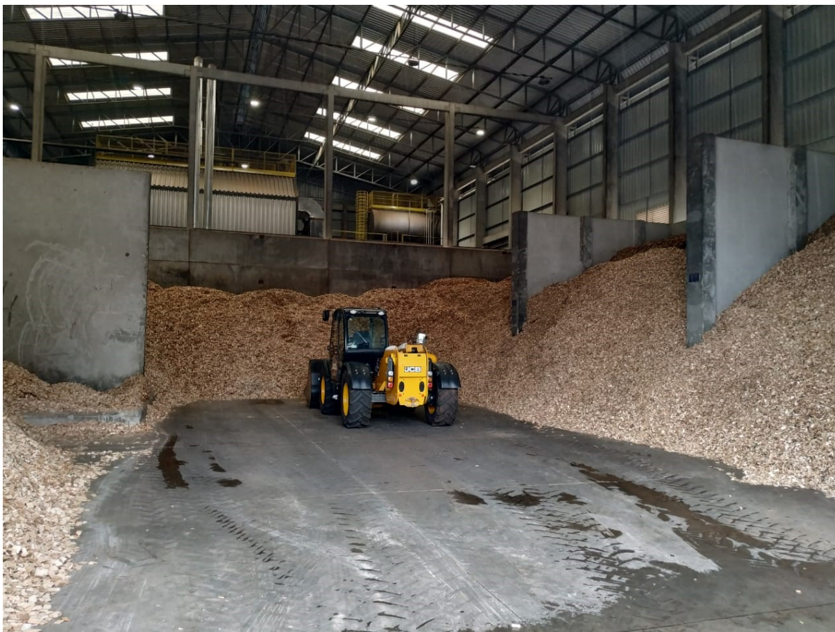
Figura 3: Barracão de armazenamento do cavaco
