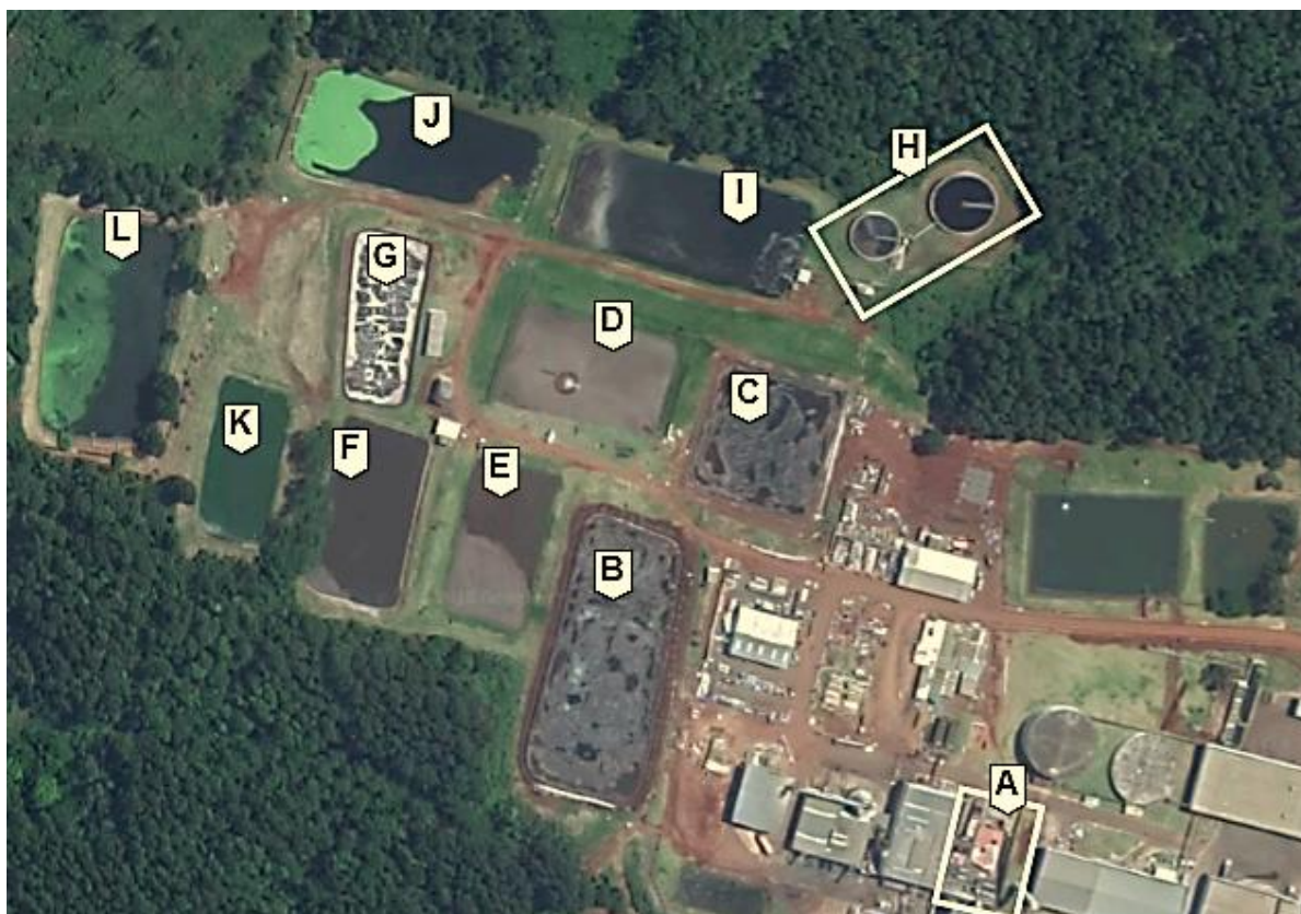
Figura 4 - Vista superior do sistema de tratamento de efluentes em estudo
