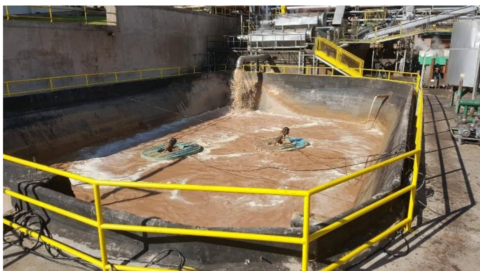
Figura 9 - Tanque de equalização. Fonte: Autoria própria (2018).
