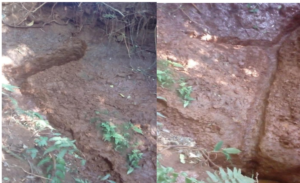
Figura 8: Construção das valas de alimentação na nascente no rio Xaxim, Matelândia, PR. Fonte: Arquivo pessoal, (2018).
