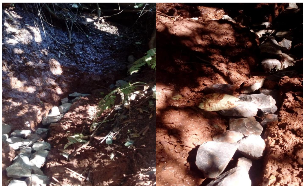
Figura 9: Colocação das pedras basálticas nas valas de alimentação na nascente do rio Xaxim, Matelândia, PR. Fonte: Arquivo pessoal, (2018).
