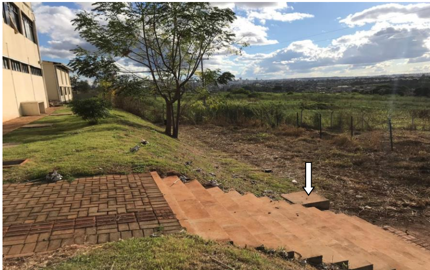
Figura 6 – Local de instalação do concentrador solar (representado por seta)
