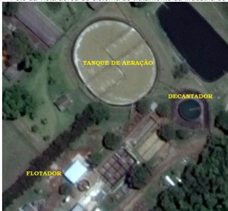
Figura 4 – Foto da vista aérea do sistema de tratamento da indústria de laticínios.
