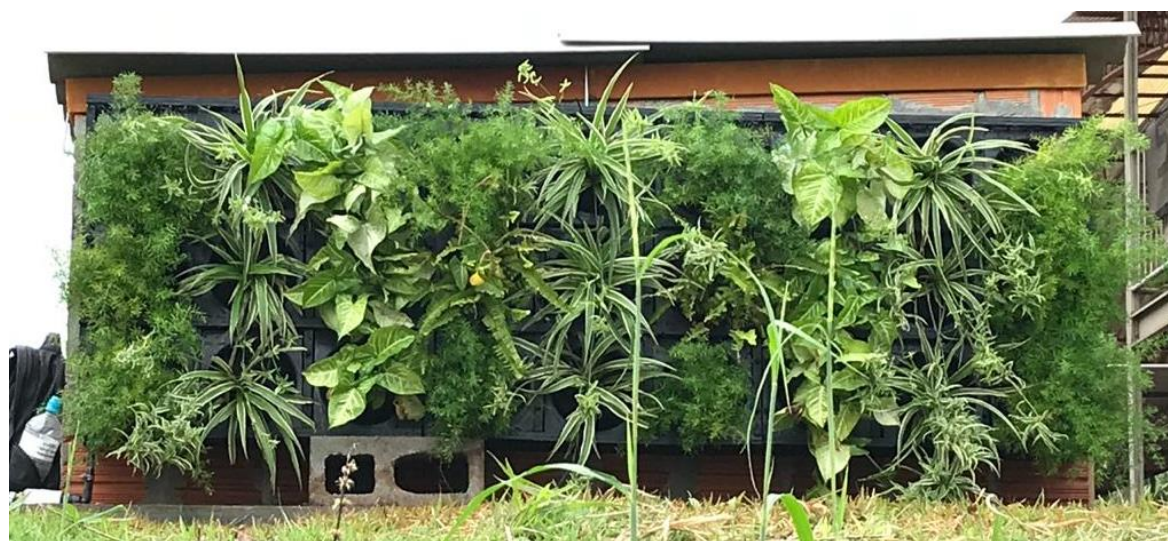
Figura 38 – Imagem do bloco com parede verde no dia da montagem do experimento
