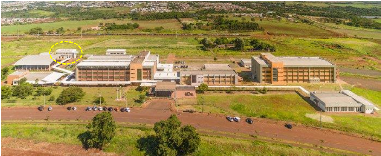
Figura 11 - Localização do prédio S na UTFPR - LD
