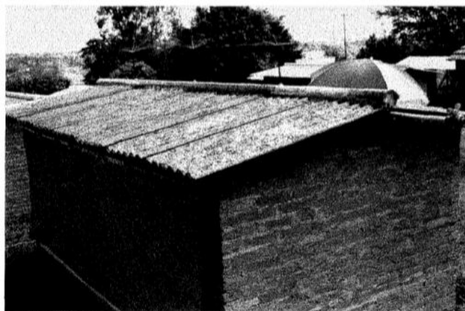
Figura 3 - Modelo em escala reduzida e distorcida com cobertura de telhas absorventes e rede de microaspersores
