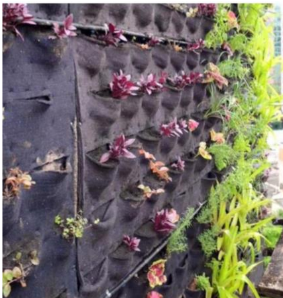
Figura 10 - Sistema intensivo de parede viva usando feltro
