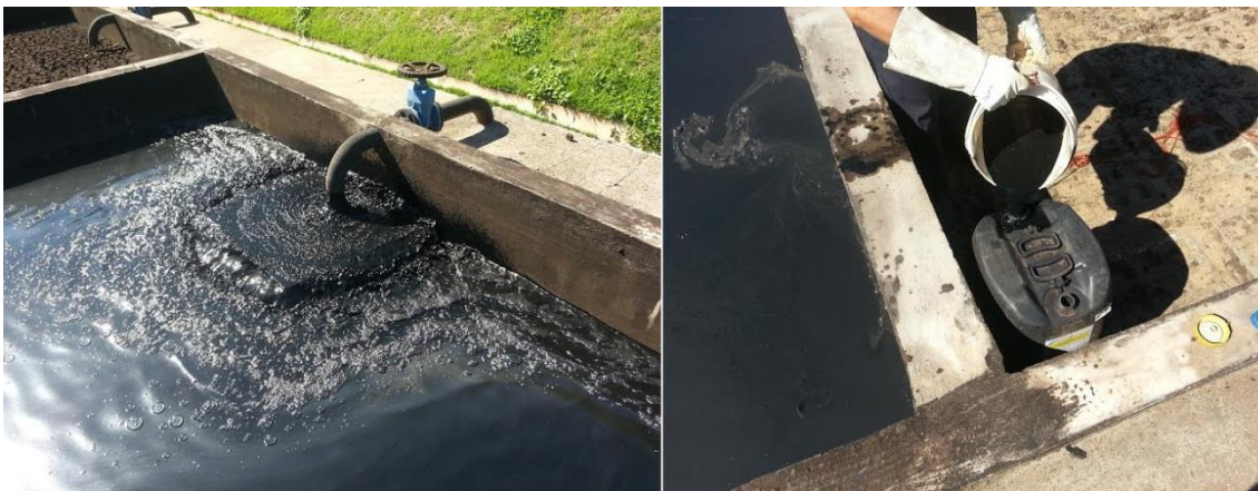
Figura 20 - Coleta da Biomassa na Estação de Tratamento de Esgoto (ETE) Esperança.
