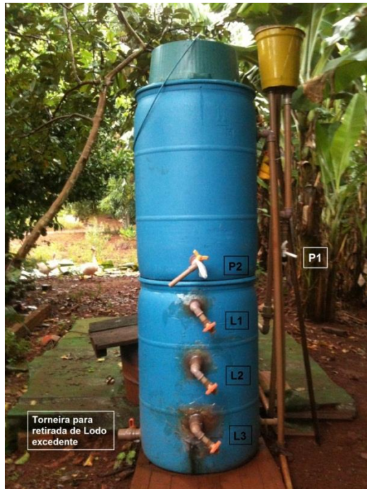
Figura 16 – Reator UASB montado na propriedade rural.
