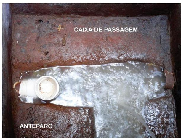
**Figura 12 - Anteparo na saída do efluente da caixa de passagem.**
