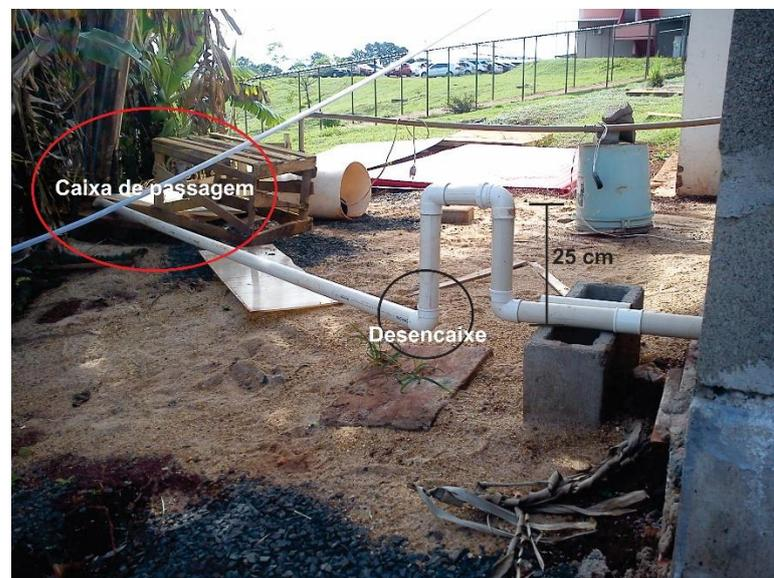
**Figura 23 - Tubulação de saída do wetland até a caixa de passagem.**
