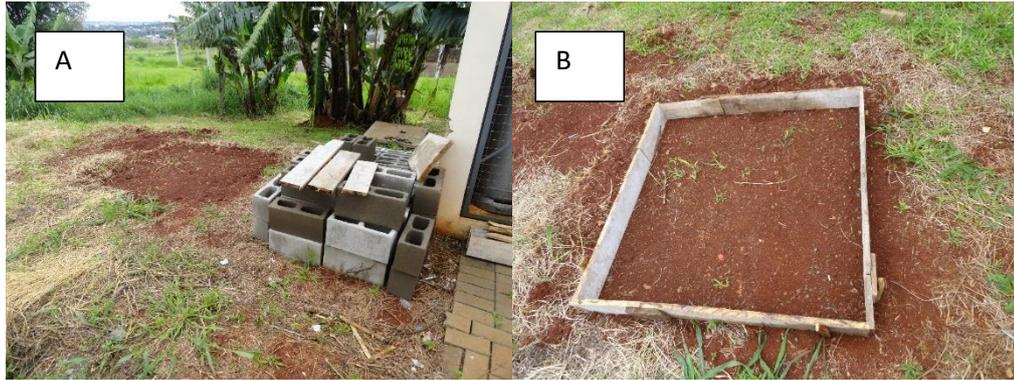
Figura 16 – (a) Limpeza do local de instalação do wetland, (b) molde de madeira para a base de concreto.
