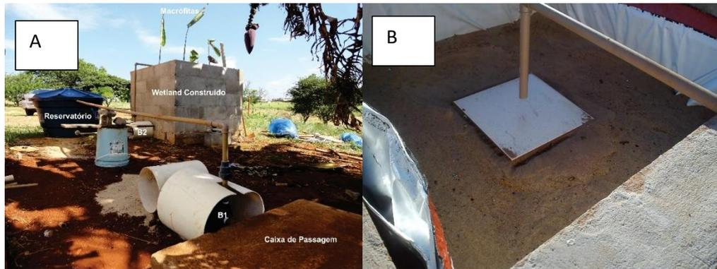
**Figura 22 – (a) Sistema Wetland Construído, (b) tablete para espalhamento de esgoto.**
