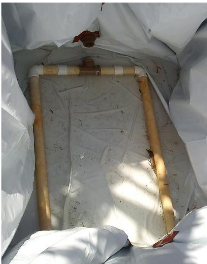
**Figura 14 - Dreno no fundo do wetland construído.**
