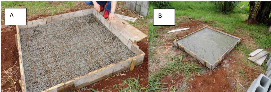
Figura 17 – (a) Depósito de brita 1 e malha de aço (4mm), (b) introdução de concreto ao molde.
