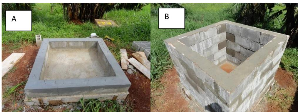
Figura 18 – (a) Primeira camada de blocos de concreto impermeabilizada e (b) estrutura em alvenaria do wetland construído.
