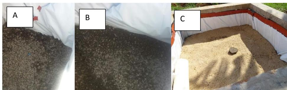
**Figura 21 – (a) Brita 2 com altura de 10cm, (b) brita 1 em 20cm, (c) camada de areia em 20cm.**
