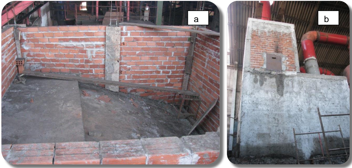
Figura 19 – a) Lavador de gases atual em construção b) Lavador de gases em operação. Fonte: CMB Consultoria Ltda. (2012).
