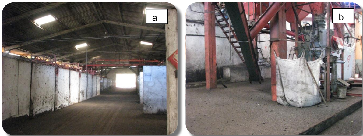
Figura 7 – a) Armazenamento de produto acabado b) Ensacamento na empresa X. Fonte: CMB Consultoria Ltda. (2012).
