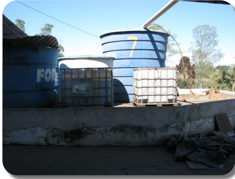
Figura 27 – Armazenamento de matéria prima líquida com bacia de contenção Fonte: CMB Consultoria Ltda. (2012).
