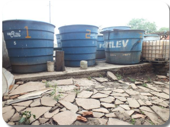
Figura 26 – Armazenamento de matéria prima líquida sem bacia de contenção. Fonte: CMB Consultoria Ltda. (2012).
