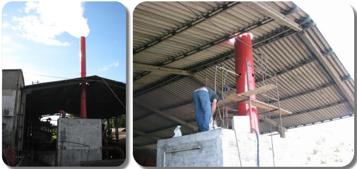
Figura 20 – Medição dos níveis de poluentes atmosféricos emitidos. Fonte: CMB Consultoria Ltda. (2012).
