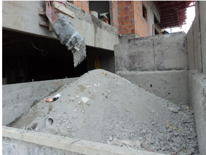
Figura 4 - Caçamba de destinação final de resíduo classe A no empreendimento A.
