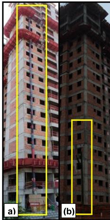
Figura 3 - Duto nos pavimentos para Empreendimentos A (a) e B (b)
