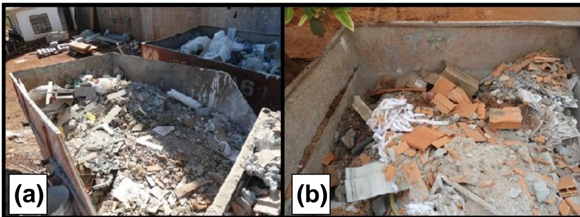
Figura 5 - Caçambas de destinação final dos resíduos classe A para os empreendimentos A (a) e B (b).
