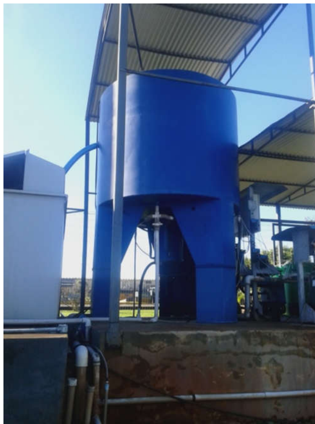
Figura 6 - Flotador por Ar Dissolvido
