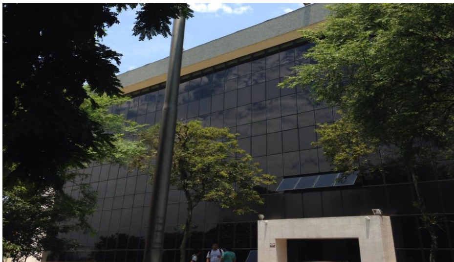
Figura 14: Fachada do edifício localizado em frente à Praça Horace Wells e do poste ornamental que sustentou o sensor 1.
