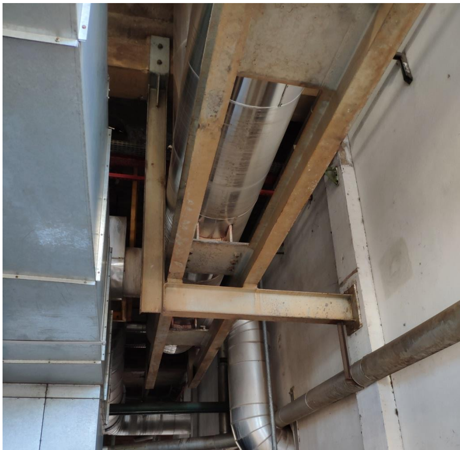
Figura 31 - Sistema de suporte de tubulação de vapor
