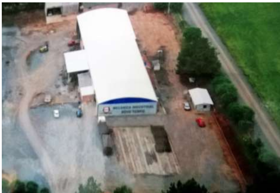
Figura 12 - Vista aérea da empresa. Fonte: Empresa Mecânica Industrial Novo Tempo, 2016.
