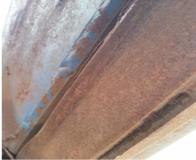
**Figura 5 - Chapa de desgaste com deformação superficial.**
