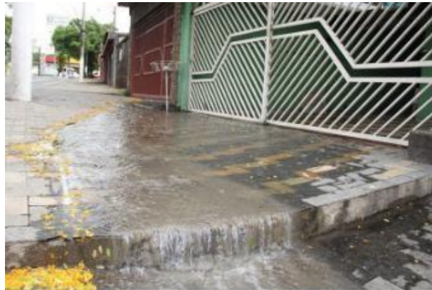
Figura 18 - Vazamento de esgoto sanitário
