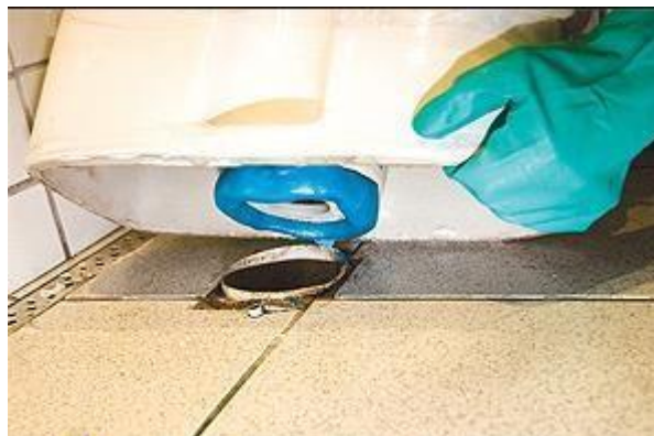
Figura 16 - Anel de vedação do vaso sanitário
