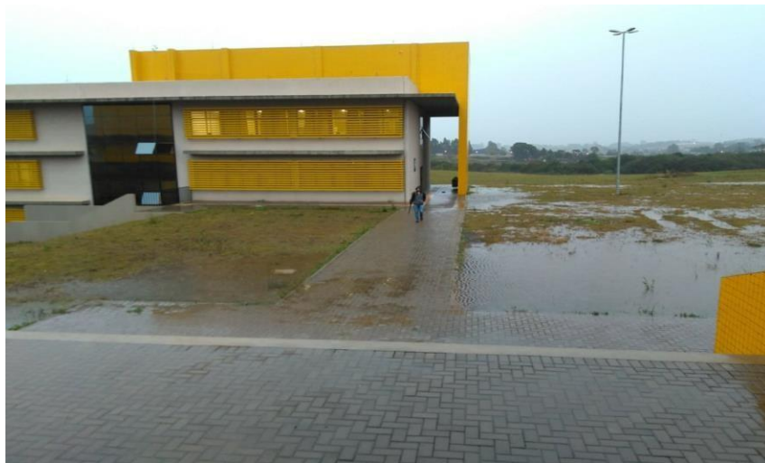
Figura 34 - Alagamentos no acesso ao bloco H
