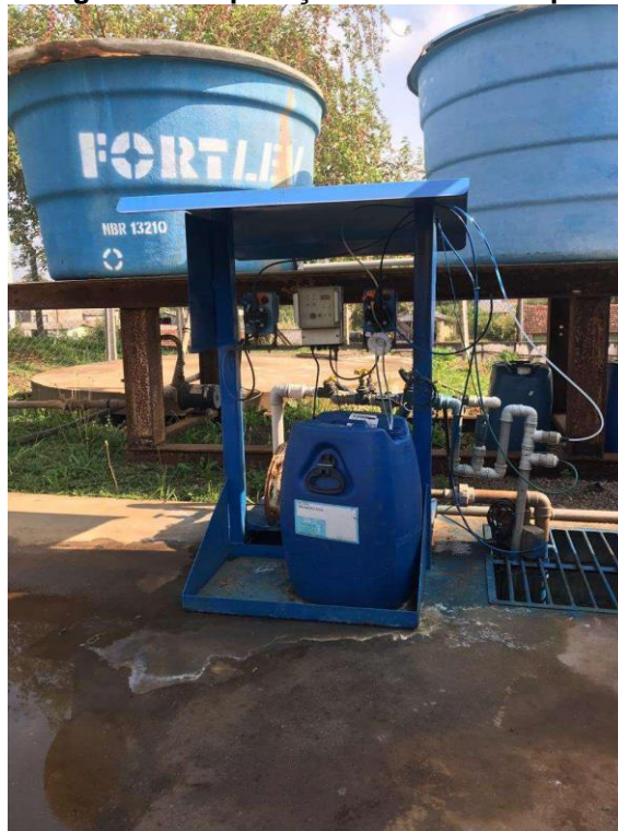
Figura 22 – Aplicação do redutor de pH
