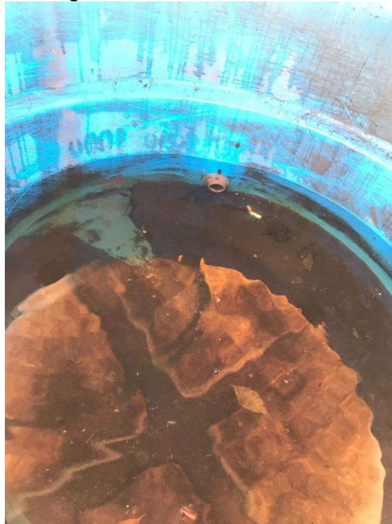
Figura 31 – Fundo do reservatório
