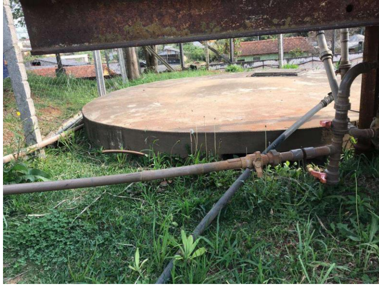
Figura 26 – Poço de captação de água do lençol freático (exterior)
