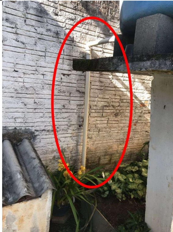
Figura 13 - Dispositivo para o esvaziamento de reservatório
