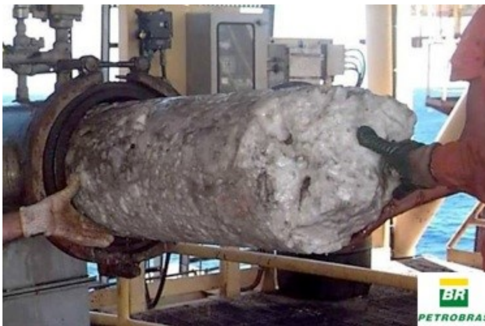
Figura 1.2 - Remoção de um plugue de hidrato de uma tubulação
