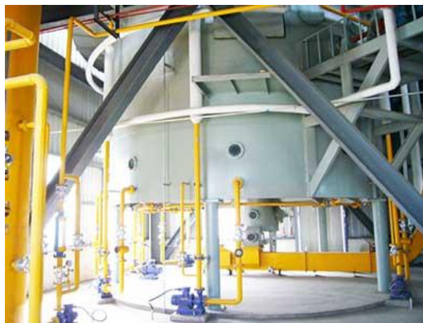
Figura 7 - Instalação de extrator rotocell
