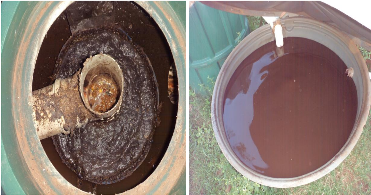
Figura 7: Esgoto bruto e tratado no sistema de tratamento por fossa séptica biodigestora Fonte: AUTORES, 2014.
