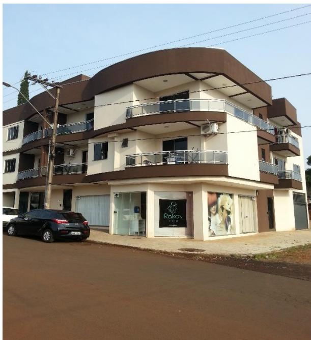
Figura 14 - Fachada do imóvel 0114 alvenaria. Fonte: O autor, (2014).
