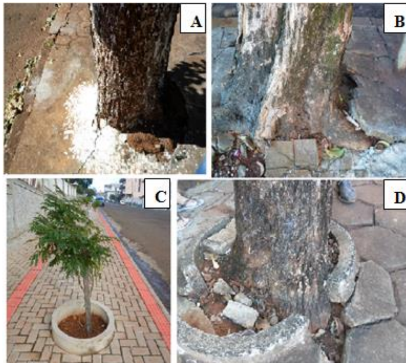
Figura 14 – Área livre para o desenvolvimento das árvores: A) Área livre inexistente; B) O que acontece quando não existe área livre; C) Plantio em manilhas; e D) O que ocorre ao longo do tempo com árvores plantadas em manilhas.
