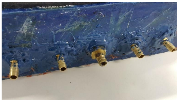
Figura 30 - Espigões instalados para a correção da falha
