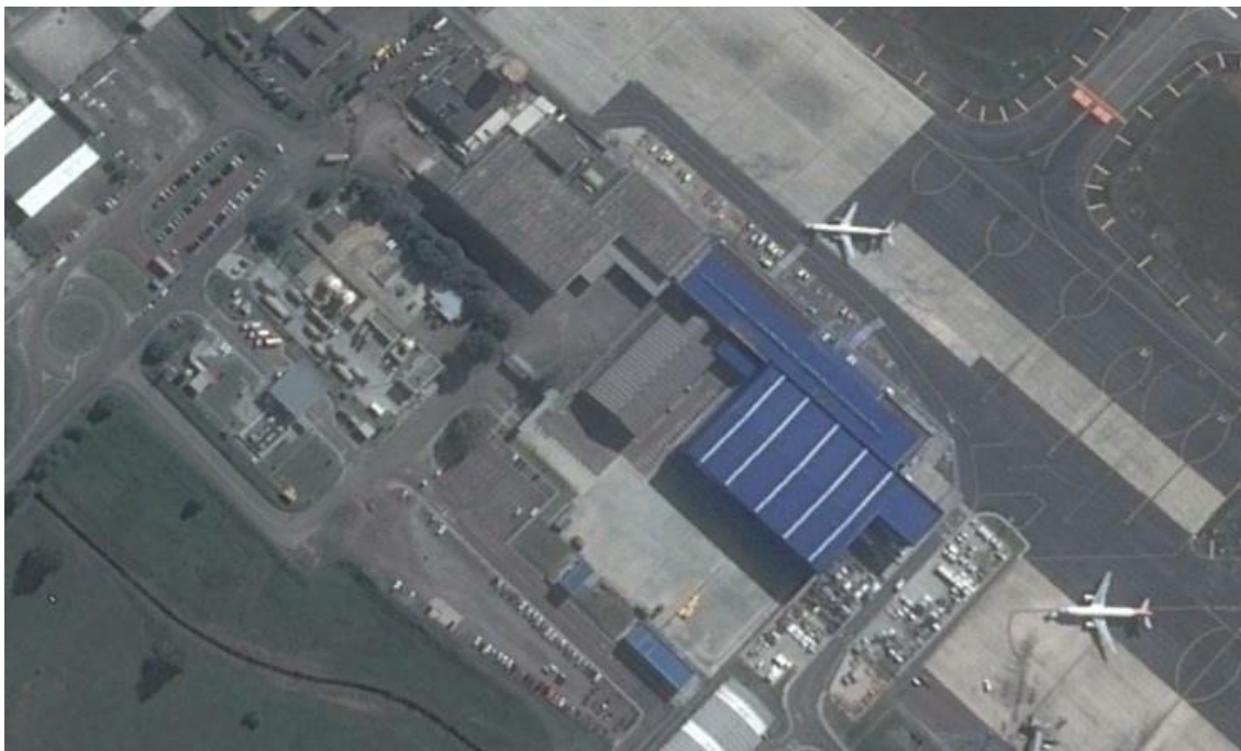
Figura 21 – Terminal de cargas – visão aérea
