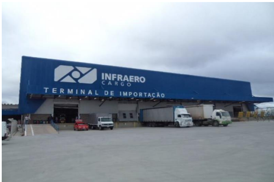
Figura 19 – Terminal de cargas – visão externa
