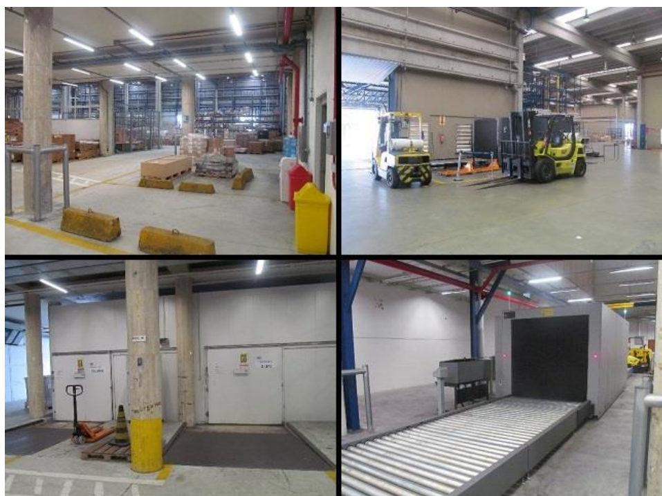
Figura 20 – Terminal de cargas – vistas internas
