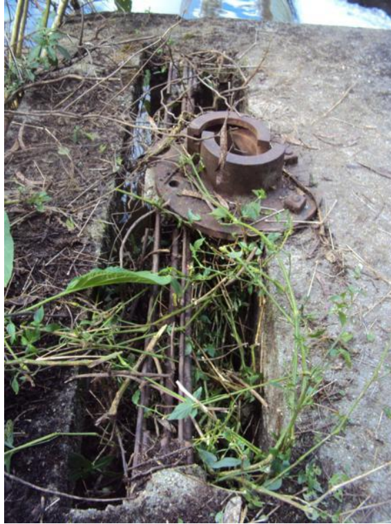
Figura 10 – Ranhura da comporta Fonte: Autoria própria.
