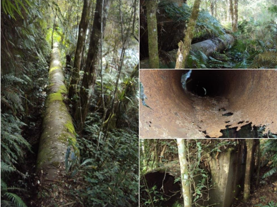
Figura 8 – Trechos do conduto forçado ao longo do seu percurso Fonte: Autoria própria.
