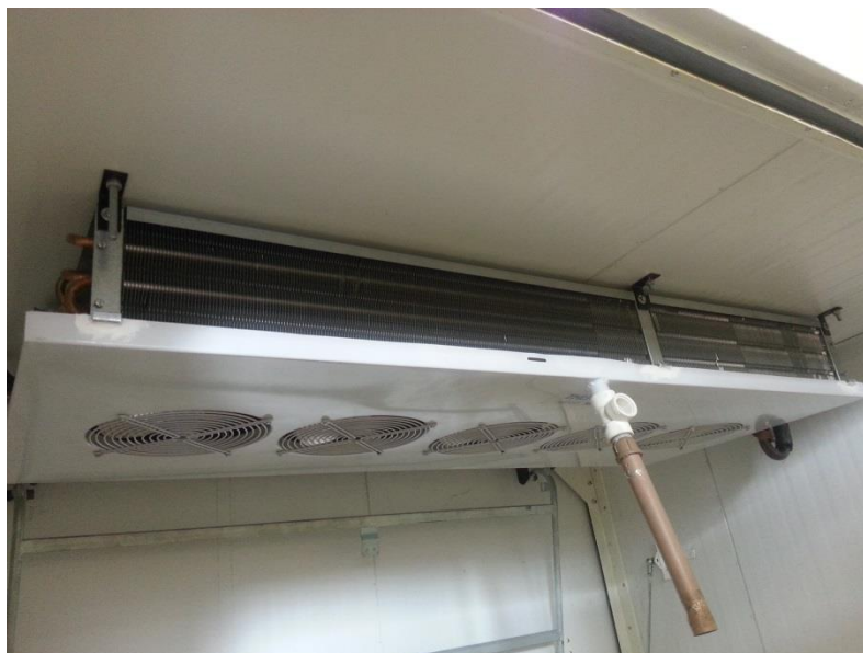
Figura 19. Evaporador Thermokey DFTC54RDE
