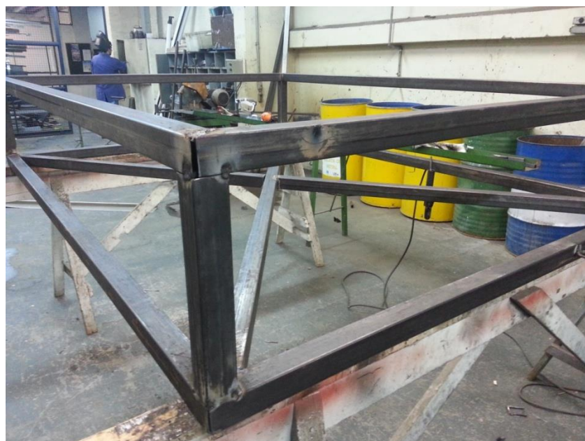
Figura 15. Estrutura de tubos quadrados em construção
