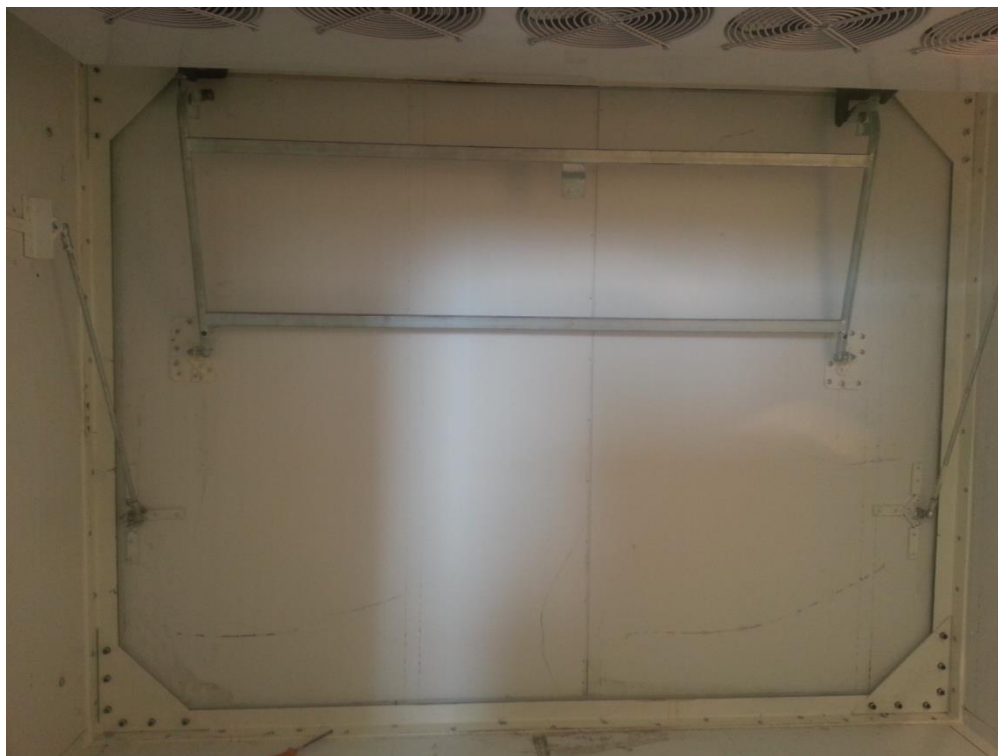
Figura 14. Estrutura da porta da câmara e cantoneiras de aço
