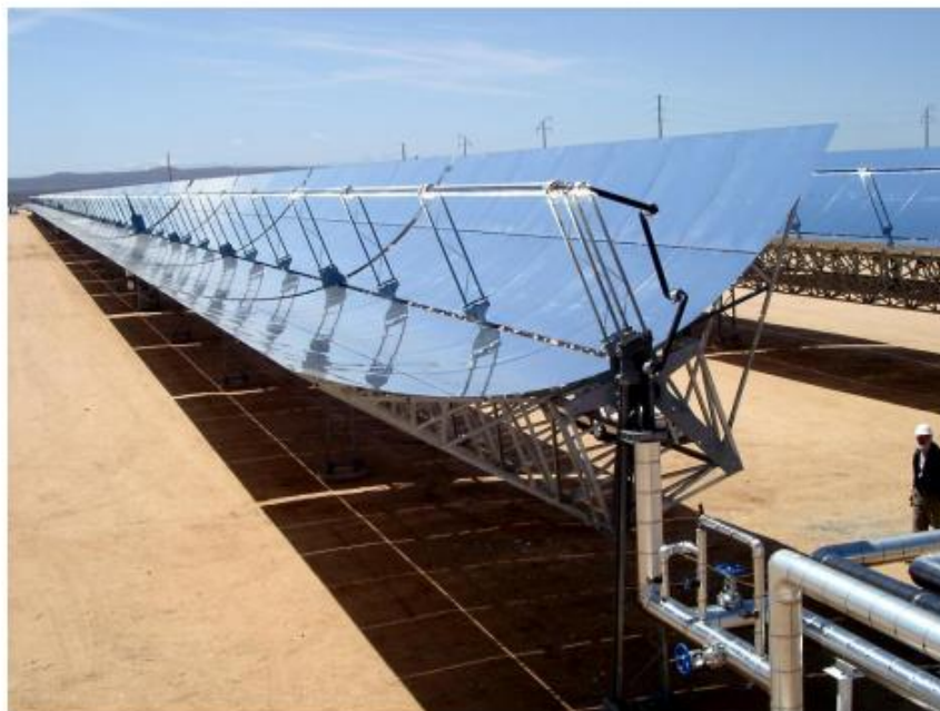
Figura 9. Concentrador Parabólico Fonte: Renewable Power News
