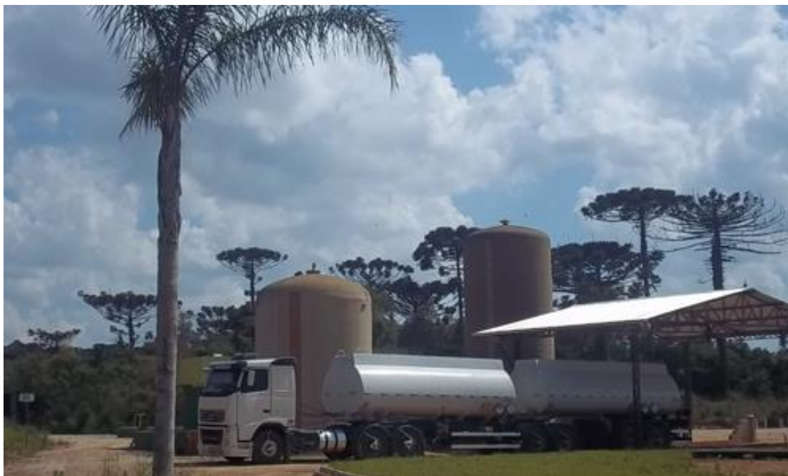
Figura 5 – Tanques de armazenamento de chorume
