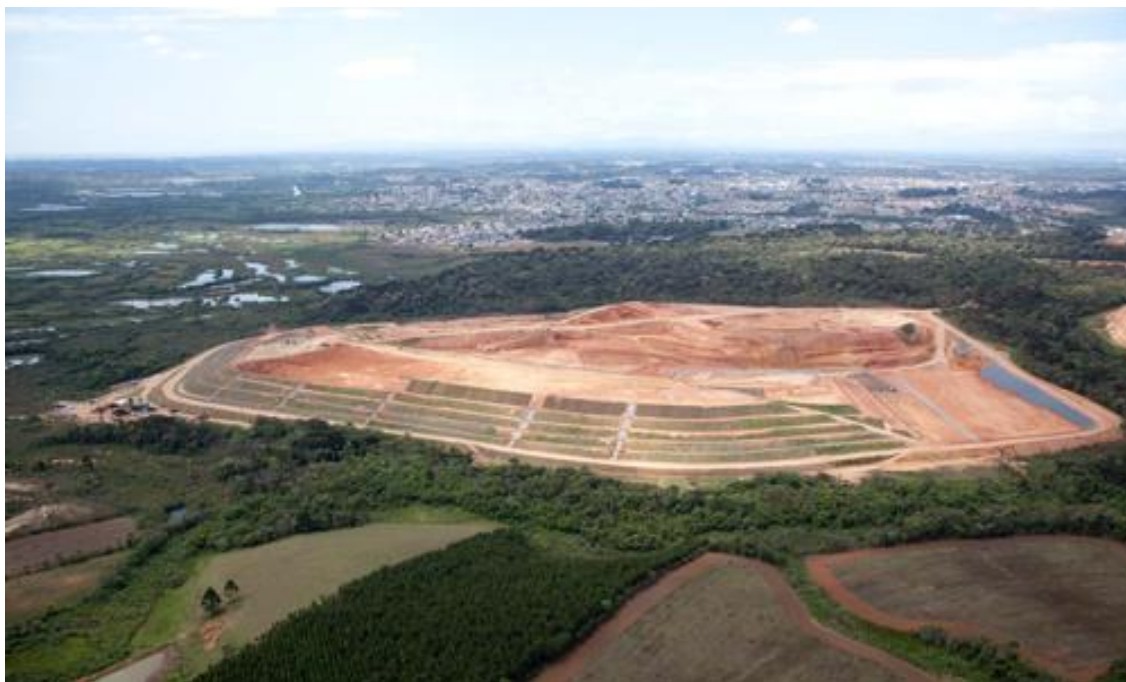
Figura 4 – Área já utilizada para deposição de resíduos
