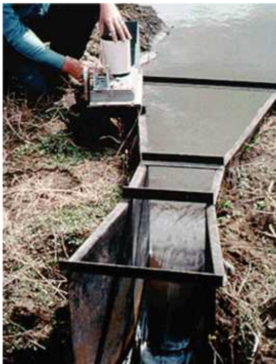
Figura 11 - Calha Parshall
