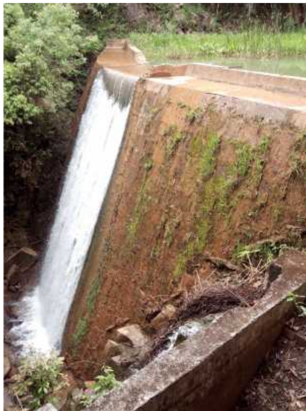
Figura 1 - Barragem existente na propriedade
