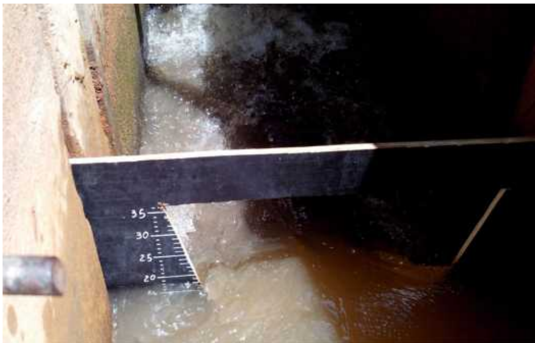
Figura 30 - Placas de madeirite instalada no canal de adução
