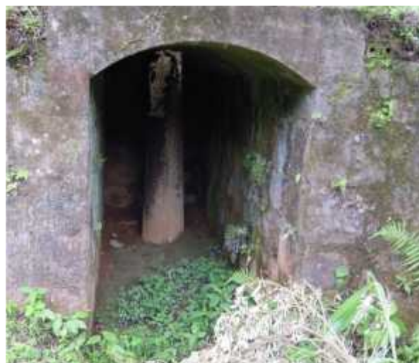
(b) – Parte inferior da casa de máquinas
