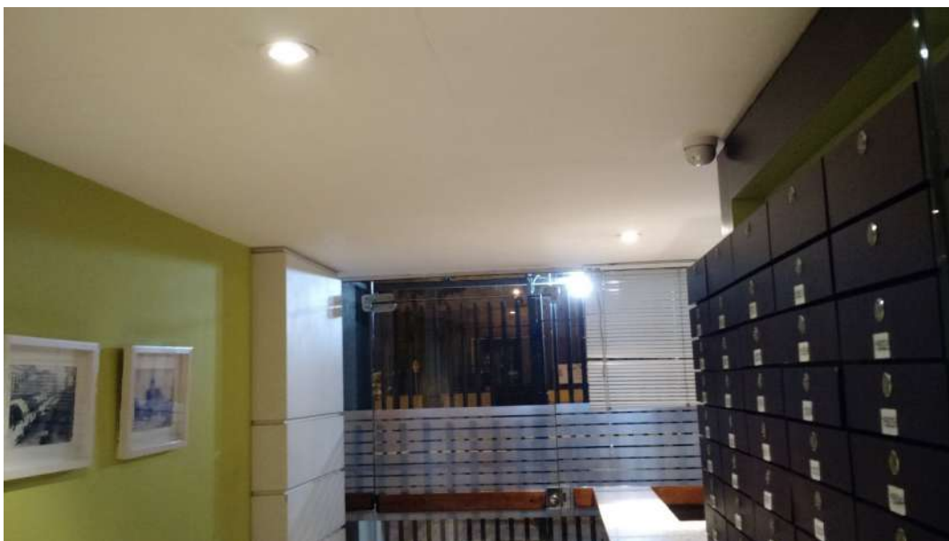
Figura 13 - Iluminação Portaria do Edifício.
