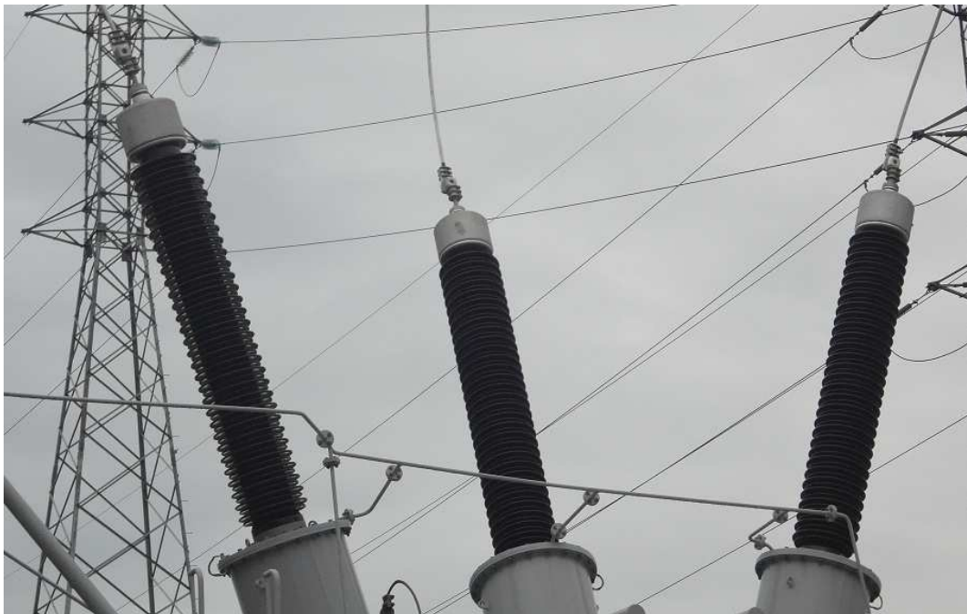
Figura 8 – Bucha do tipo condensiva. Fonte: Autoria Própria (2014).
