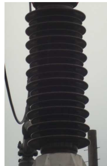
Figura 6 – Bucha do tipo sólido ou não condensativa. Fonte: Autoria Própria (2014).
